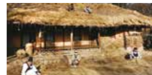
초가집 새지붕 없는날 11월 중 현 지붕 탈기, 이엉 잇기, 용마름 올리기
