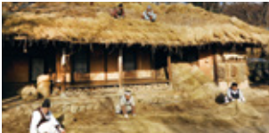
草葺き家の屋根を取り替える日 11~12月
